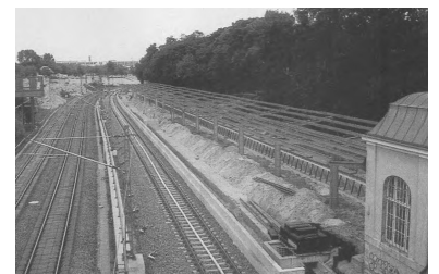
Wiederaufbau der S-Bahnhöfe Eichkamp (Bild oben mit Regionalbahn von Falkensee nach Berlin-Charlottenburg) und Heerstraße. Jeweils nördlich der S-Bahn-Gleise befindet sich die fertiggestellte Bahnstrecke Berlin - Hamburg. (Foto: Marc Heller (6/97))
