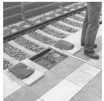
Getrübt wurde die Eröffnungsfreude durch den unverantwortlichen Zustand des neuen Bahnhofs Spandau. Noch nicht einmal die provisorischen Warthäuschen mit den vorerst einzigen Überdachungen und Sitzmöglichkeiten standen zur Verfügung. Bei den Zugzielanzeigern funktionierte nur die Uhr, und überall lösten sich die neu verlegten Bahnsteigplatten. Welches Unternehmen würde seinen Kunden zur Laden- oder Büroeröffnung solche Zustände zumuten? (Foto: Marc Heller)
