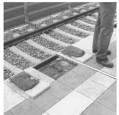
Getrübt wurde die Eröffnungsfreude durch den unverantwortlichen Zustand des neuen Bahnhofs Spandau. Noch nicht einmal die provisorischen Warthäuschen mit den vorerst einzigen Überdachungen und Sitzmöglichkeiten standen zur Verfügung. Bei den Zugzielanzeigern funktionierte nur die Uhr, und überall lösten sich die neu verlegten Bahnsteigplatten. Welches Unternehmen würde seinen Kunden zur Laden- oder Büroeröffnung solche Zustände zumuten? (Foto: Marc Heller)
