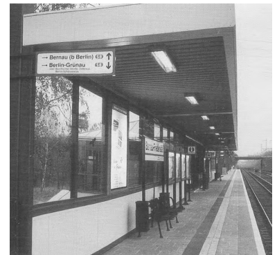
Der neue S-Bahnhof am eingleisigen Streckenabschnitt zwischen Bernau und Zepernick. (Foto: Marc Heller (11/97))
