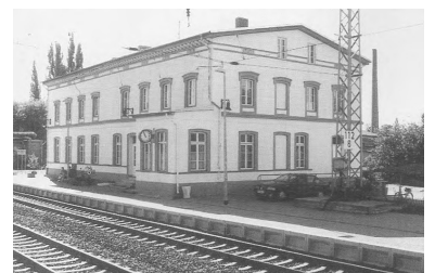
Historisch getreu hergerichtet präsentiert sich der Bahnhof Bad Wilsnack - allerdings ohne Funktion für die Bahnkunden. Hier könnte das touristische Potential der Kurstadt am Standort Bahnhof ausgeschöpft werden. (Foto: Frank Böhnke)
