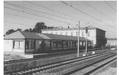
Alt und neu prallen aufeinander. Am Bahnhof in Glöwen wird deutlich, daß der Bahnhof als Gesamtensemble betrachtet werden muß. Während am alten Empfangsgebäude der Putz abblättert, wirkt der neue Tunnelzugang wie aus einem Baumarkt-Katalog. (Foto: Frank Böhnke)
