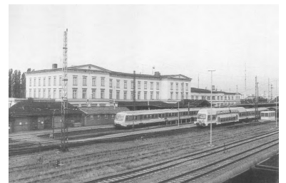
5.000 m 2 Nutzfläche mit Gleisanschluss zu vermieten. Sie suchen ein schönes geräumiges Büro? Oder einen Tanzsaal? Kein Problem. Im Bahnhof Wittenberge bekommen Sie alles! Für das Empfangsgebäude der Prignitzstadt werden schon bald neue Nutzer gesucht. Denn 1999 sollen die Gleise der Magdeburger Seite zugunsten eines Vorplatzes verschwinden und gemeinsam mit den Berliner Gleisen an der Ostseite vereinigt werden. Die neuen Bahnsteige samt Tunnel liegen dann nördlicher als heute, weshalb die Bahn dort ein neues Empfangsgebäude bauen will. (Foto: Frank Böhnke)
