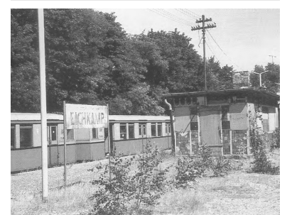
Der S-Bf Eichkamp im Juni 1986 und zwei Wochen vor der Wiederinbetriebnahme am 16. Januar 1998. (Foto: Udo Dittfurth)
