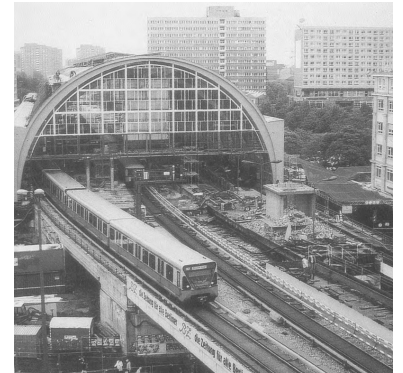
Bf Alexanderplatz im Mai 1997. Die Abbrucharbeiten an der Fernbahntrasse auf der Stadtbahn sind in vollem Gange. Ein Jahr später, am 24. Mai 1998, sollen die Züge wieder zwischen Zoo und Hbf fahren können, wobei alle Regionalzüge hier am Alexanderplatz halten werden. Die Wiederherstellung der Stadtbahn nimmt die DB AG zum Anlaß, das Regionalverkehrsnetz in Brandenburg und Berlin wesentlich zu verändern. (Foto: Marc Heller)
