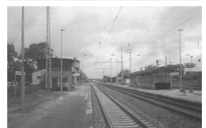
Bf Löwenberg (Mark). Die Fahrgäste von Löwenberg gelangen zukünftig auf zwei Routen
