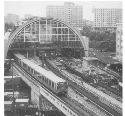
Bf Alexanderplatz im Mai 1997. Die Abbrucharbeiten an der Fernbahntrasse auf der Stadtbahn sind in vollem Gange. Ein Jahr später, am 24. Mai 1998, sollen die Züge wieder zwischen Zoo und Hbf fahren können, wobei alle Regionalzüge hier am Alexanderplatz halten werden. Die Wiederherstellung der Stadtbahn nimmt die DB AG zum Anlaß, das Regionalverkehrsnetz in Brandenburg und Berlin wesentlich zu verändern. (Foto: Marc Heller)
