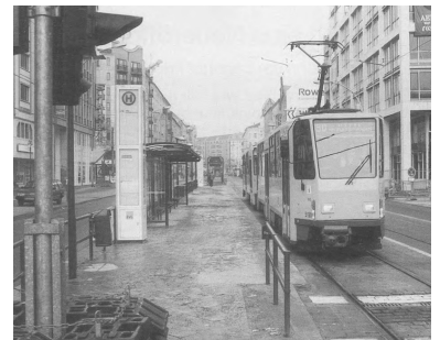
Vorbildlich. Am U-Bf Oranienburger Tor wurde eine gemeinsame Haltestelle für Tram und Bus gebaut. Dies wäre auch am Bf. Friedrichstraße sinnvoll gewesen. (Foto: Ivo Köhler)
