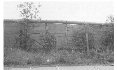
Unterbrochene Bahnstrecke nach Falkensee 1976. Die Hamburger Bahn durch die Berliner Mauer unterbrochen. Der Fernverkehr wurde über Wannsee bzw. ab 1976 über Staaken geführt. Der letzte Zug verkehrte am 5.12.1961, als ein Personenzug aus Oranienburg nach Albrechtshof hier die Grenze durchbrach. Die S-Bahn verkehrte bis zum 13.8.61 Richtung Falkensee und fehlt heute noch an dieser mittlerweile geschlossenen Eisenbahnücke. (Foto: Sammlung Münzinger, Bln.)
