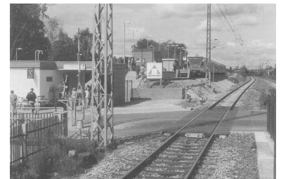
Nichts bleibt, wie es ist - der S-Bahnhof Blankenfelde. (Foto: Christian Schultz, 1992)
