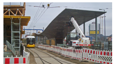
Das filigrane Beton-Haltestellendach wurde nicht rechtzeitig fertig. Die Straßenbahn fährt provisorisch eingleisig durch die Baustelle zur Ersatzhaltestelle. Während mehrerer abendlicher Betriebseinstellungen wurde das Schalgerüst abgebaut. (Foto: Florian Müller, 23.1.2015)
