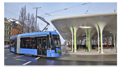
Am Ausgangspunkt der vollständig neugebauten Linie 23 nach Schwabing Nord, über dem viergleisigen U-Bahnhof Münchner Freiheit, entstand nach Plänen des Aachener Architekturbüros OX2 eine extravagante Überdachung der Haltestellenanlage. Daneben eine Variobahn von Stadler Rail (in München »Baureihe S«). Die ab 2009 ausgelieferten Fahrzeuge haben wiederholt Probleme bereitet. Inzwischen ist bei ihnen ein »Serienschaden« diagnostiziert worden. (Foto: MVG/Wolfgang Wellige)
