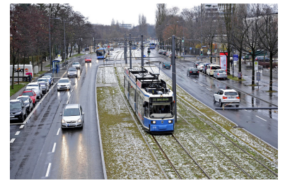
Die Ende 2011 eröffnete Strecke nach St. Emmeram (hier in der Engelschalkinger Straße) verläuft vollständig auf eigenem Bahnkörper, der als Rasengleis ausgeführt wurde. Wagen 2111 gehört zur siebzig, 1995-1997 ausgelieferte Wagen umfassenden Münchner Baureihe R 2.2. Dahinter verbirgt sich das auch in Berlin verbreitete Modell GT6N, gebaut von AEG/Adtranz. (Foto: SWM/MVG)
