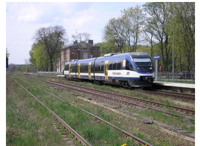
Bahnhof Seelow-Gusow. Trotz des massiven Abbaus von Weichen und Überholgleisen (mit der Folge verminderter Streckenkapazitäten) reichten die Instandhaltungsmittel für die Schieneninfrastruktur im Rahmen der LuFV I bei weitem nicht aus. (Foto: Christian Schultz)
