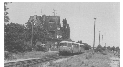
Der Bahnhof Ziesar ist der bedeutendste Bahnhof der Strecke Güssen-Ziesar. Gleichzeitig ist er die einzige Station dieser Strecke in Brandenburg; der Rest liegt in Sachsen-Anhalt. Dieses Land möchte die Strecke weiter bedient haben. (Foto: Th. Kabisch, 7. Juni 1996)
