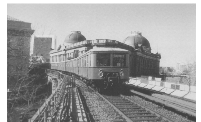
S-Bahn auf Fernbahngleisen zwischen Bode- und Pergamonmuseum während der Stadtbahn-Sanierung 1995. (Foto: Marc Heller)
