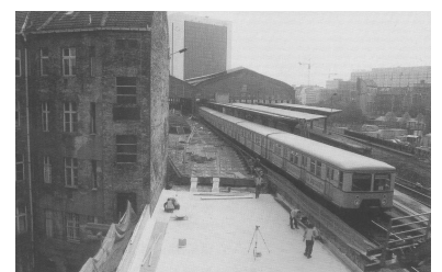
Stadtbahn-Sanierung 1995: Bau der »Festen Fahrbahn« für die S-Bahn am Bahnhof Friedrichstraße (Foto: Dirk Riediger)
