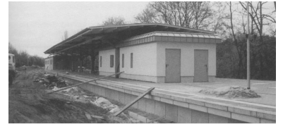
Der neue S-Bahnsteig Bahnhof Heiligensee. (Foto: Marc Heller)
