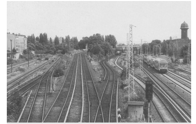
Hier gehört sie hin: die (noch?) fehlende Verbindung von der Ostbahn zur Stadtbahn zwischen Ostkreuz (Bildhintergrund) und Ostbahnhof. (Foto: Marc Heller, September 1998)
