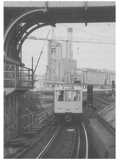
... Zug der U2 vor den DEBIS-Bauten. (Foto: Marc Heller, 1998)
