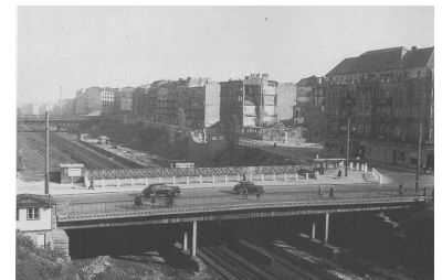
Die heutige Julius-Leber-Brücke mit den Resten des S-Bahnhofs Kolonnenstraße. Später wurde die Brücke nach Süden durch ein separates Bauwerk (mit nur einer Mittelstützenreihe) für Kfz-Verkehr und für Fußgänger erweitert. Auf der Nordseite entstand ein separater Fußgängersteg. Aufnahme vom Oktober 1950. (Foto: Schöneberg Museum)
