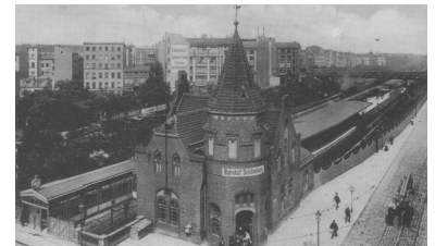
Der 1891 erbaute Bahnhof Schöneberg an der Kolonnen- Ecke Siegfriedstraße (r.). Am nördlichen Ende des Bahnsteigs besteht die Übergangsmöglichkeit zum Wannseebahnhof Großgörschenstraße durch einen Tunnel (auch «Hammelgang» genannt), der später durch einen hölzernen Steg ersetzt wurde. (Foto: Schöneberg Museum)
