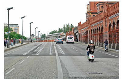
Oberbaumbrücke zwischen Friedrichshain und Kreuzberg: Hier wurden bereits 1994 Schienen für eine künftige Straßenbahnverlängerung von der Endhaltestelle am U-Bahnhof Warschauer Straße Richtung Hermannplatz verlegt. Doch wann diese wichtige Strecke gebaut wird, ist vollkommen ungewiss. (Foto: Jan Gympel)
