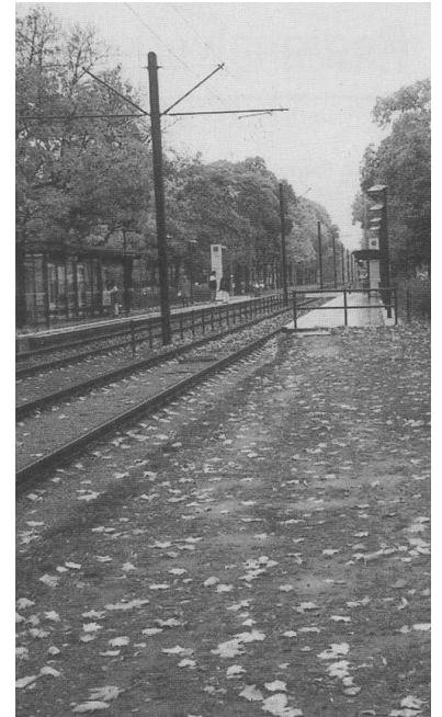
Straßenbahn-Haltestelle Osrarn-Höfe in der Seestraße: Hier gehört ein zweiter Bahnsteigzugang hin! (Foto: Jens Wieseke, Oktober 1998)
