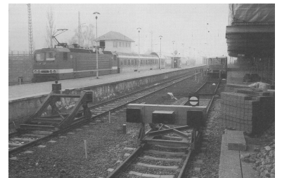
Prellbock im S-Bahn-Gleis im Bahnhof Hennigsdorf. (Foto: Florian Müller, November 1998)
