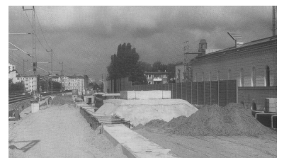
Juni 1998: Im neuen Bahnhof Stresow, dem ehemaligen Bahnhof Berlin-Spandau, halten künftig nur noch die Züge der S-Bahn. Das Foto zeigt in der Mitte die Bahnsteigfundamente und im Hintergrund das Schotterbett für eines der beiden S-Bahn-Gleise. Weder das historische Empfangsgebäude noch das Rathaus Spandau wird der Fahrgast aus der S-Bahn sehen, da entlang der Strecke die Schallschutzwände den Blick versperren - Ähnlichkeiten mit früheren Fahrten in Transitzügen durch das Grenzgebiet sind rein zufällig! (Foto: H.-P. Schwarz)
