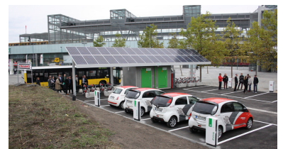
Elektrische Mietautos, Mietfahrräder, E-Bus-Ladestelle und Solarstromgewinnung auf dem Bahnhofsvorplatz. (Foto: DB AG)
