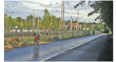
Im Ruhrgebiet wird auf der Trasse der ehemaligen Rheinischen Bahn ein Radschnellweg zwischen Essen und Duisburg angelegt. Das Foto zeigt den neu asphaltierten Radweg (Mitte), begleitet von einem gesplitteten Fußweg (rechts), am Bahnhof Mülheim/Ruhr (links). Auf der Berlin-Potsdamer Stammbahn-Trasse kämen - so der Plan - noch Beleuchtung, Rampen, Brücken, Fahrrad-Parkhäuser und Service-Stationen hinzu. Da wäre es lebensfremd zu glauben, dass so ein Radweg in 10 oder 20 Jahren zugunsten einer Bahnlinie zurückgebaut werden könnte. Deshalb ist auch die vermeintlich »temporäre Nutzung« faktisch der dauerhafte Ausstieg aus dem Bahnbetrieb, die Option auf eine Reaktivierung der Stammbahn wäre im Wortsinne »verbaut«. (Foto: Florian Müller, Sep. 2015)
