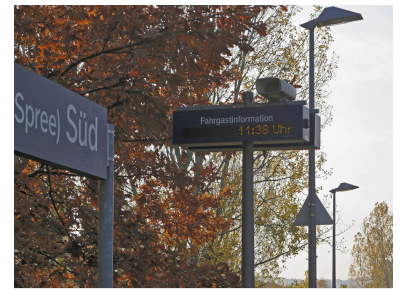
Zumindest ein solcher »Dynamischer Schriftanzeiger« (hier in Fürstenwalde (Spree Süd)) muss auf jeder Bahnstation vorhanden sein, um die Fahrgäste über Störungen aller Art aktuell informieren zu können. Das ist jetzt durch das Bundesverwaltungsgericht abschließend entschieden worden. (Foto: Stefan Retzlaff)
