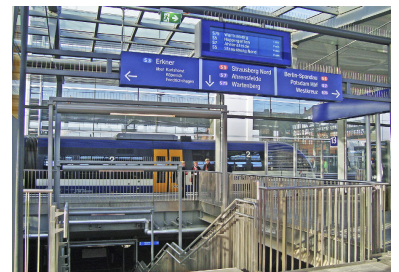
Regionalbahnsteig auf dem Ring mit kurzen Umsteigewegen zu allen Bahnsteigen unten auf der Stadtbahn. Ärgerlich und unverständlich ist, dass die Deutsche Bahn nicht sofort auch die von der S-Bahn aufwärtsführende Fahrtreppe gebaut hat. Der Platz dafür ist berücksichtigt. (Foto: Florian Müller)
