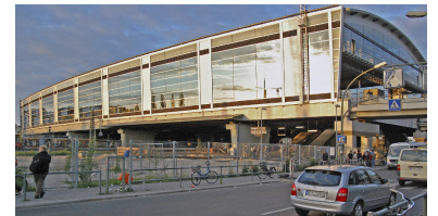
Wie eine riesige, klobige Truhe, die jeden Moment auf die unter ihr liegende Stadtbahntrasse zu plumpsen droht: Die neue Ringbahnhalle im Eröffnungsjahr 2012. (Foto: Jan Gympel)
