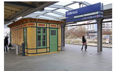
Historische Erinnerungsstücke auf dem neuen Bahnsteig D: Rekonstruiertes Aufsichtshaus und wiederverwendete Dachstützen. Im Hintergrund der Rest der Nordringkurve. (Foto: Jan Gympel)
