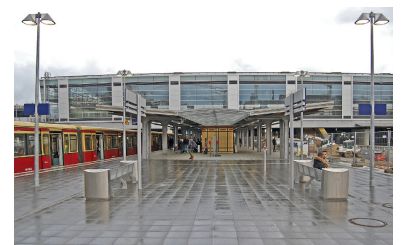
Blick über den neuen Bahnsteig D auf die Ringbahnhalle. Auf der noch freien Fläche im Vordergrund soll das Treppenhaus zur nachgebauten Fußgängerbrücke errichtet werden. (Foto: Jan Gympel)
