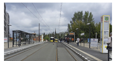
Die M 10-Haltestelle am Nordbahnhof in Standardausführung. Die Wartehalle steht ohne Zwang so dicht am Gleis, dass sich Ein- und Aussteiger gegenseitig behindern. Ein vom Alexanderplatz bekanntes Problem, das hier wiederholt wurde. (Foto: Tom Gerlich)
