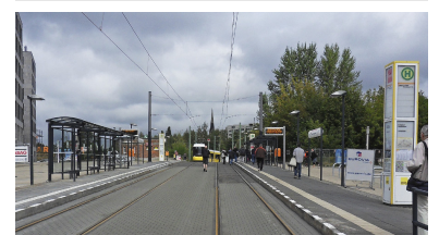
Die M 10-Haltestelle am Nordbahnhof in Standardausführung. Die Wartehalle steht ohne Zwang so dicht am Gleis, dass sich Ein- und Aussteiger gegenseitig behindern. Ein vom Alexanderplatz bekanntes Problem, das hier wiederholt wurde. (Foto: Tom Gerlich)
