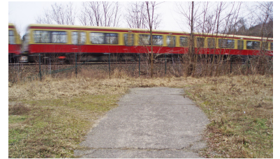
Bei der Dresdener Bahn endet der Mauerweg noch immer an den Gleisen. Aber mit dem Planfeststellungsbeschluss für den Ausbau der Dresdener Bahn auf Berliner Gebiet sind die Chancen gestiegen, dass auch hier in Blankenfelde-Mahlow eine Unterführung für den Mauerweg gebaut und somit die letzte Lücke im Weg geschlossen wird. (Foto: Michael Cramer, 2012)
