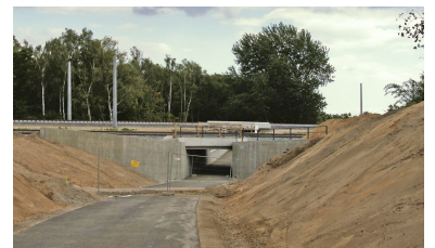
Juli 2004. Beim Ausbau der Anhalter Bahn wurde die Mauerweg-Unterführung problemlos berücksichtigt. (Foto: GEB-Archiv)
