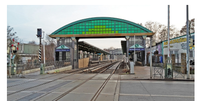
S-Bahnhof Buckower Chaussee. Der Bahnübergang wird durch eine Straßenerüberführung ersetzt. Auch der »Rümler'sche Bahnhofsbogen« wird abgebaut, dort werden künftig die Treppenhäuser stehen. Dieser S-Bahnhof wurde erst 1988 bis 1990 von der BVG nach Plänen ihres damaligen Architekten Rainer G. Rümmler neu gestaltet. (Foto: Florian Müller)
