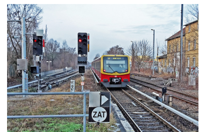
Nordausfahrt S-Bahnhof Marienfelde. Leider wurde bei der Planung versäumt, einen neuen Nordausgang anzulegen. Fußweg und Treppe zwischen den Gleisen zur Unterführung Großbeerstraße wären nur wenige Meter weit - das verdeutlicht der Pfeil auf das Brückengeländer. Da die Brücke ohnehin neu gebaut werden muss, wäre es kein Mehraufwand. (Foto: Florian Müller)
