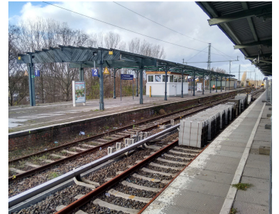
Regionalbahnsteig in Berlin-Schöneweide. Noch fährt die RB 24 ohne Halt durch, aber ab 21. März sollen die Züge hier halten können. (Foto: Holger Mertens)
