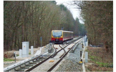
Endlich im 20-Minuten-Takt. Zug nach Stausberg Nord auf dem neuen Begegnungsgleis, gesehen vom Bahnsteig Hegermühle. (Foto: Florian Müller)
