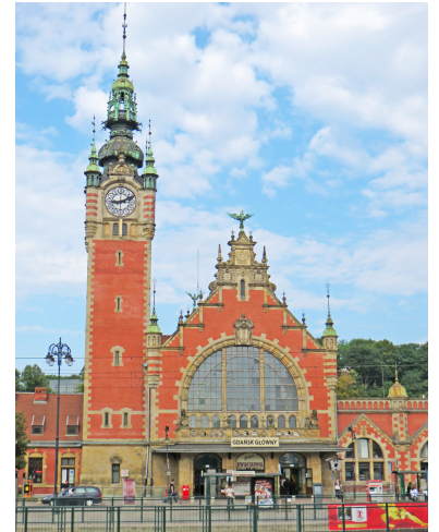
Bahnhof Gdansk Główny (Danzig Hbf). Fortschritte beim Streckenausbau ermöglichen seit dem Fahrplanwechsel im Dezember 2015 erfreuliche Fahrzeitverkürzungen zwischen Berlin und Gdansk/Sopot/Gdynia. Doch mit nur einem durchgehenden EuroCity-Zugpaar ist das Angebot noch sehr bescheiden. (Foto: Christian Schultz)
