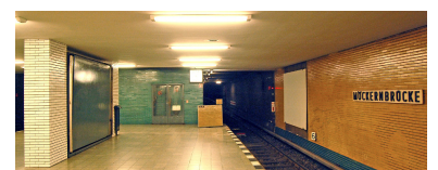
Noch ihrer »Grundinstandsetzung« harrt die 1966 eröffnete Bahnsteighalle an der Möckernbrücke. Keramikriemchen, gerade Linien, rechte Winkel, abgehängte Putzdecke und eine Beschilderung, die man gut lesen kann - lange wird man dies vermutlich auch hier nicht mehr finden. Man beachte: Auch damals gab es schon helle Bodenbeläge - anders als heute üblich aber mit einer Musterung, auf der Schmutz kaum auffällt. Und der Drang nach Transparenz ging auf vielen seinerzeit gebauten Stationen so weit, dass selbst die Wasseranschlüsse nicht hinter Blech versteckt, sondern hinter Glas gezeigt wurden. (Foto: Jan Gympel)
