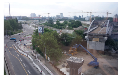
Die S21-Brücke über die Perleberger Straße ist bereits eingebaut. Daran schließt sich der Bereich für den geplanten S-Bahnhof Perleberger Brücke an. Für dieses Projekt soll 2016 nun endlich eine Kostenschätzung gemacht werden. Die erste! (Foto: Florian Müller, Juli 2016)
