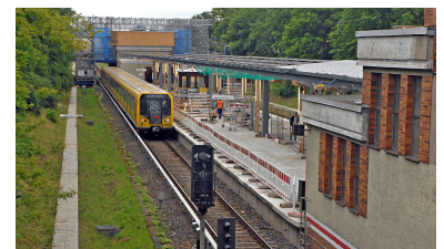
Baustelle (oben) und geplanter Endzustand (unten). Der U-Bahnhof »Neue Grottkauer Straße« auf der U 5 wird schick gemacht für die Internationale Gartenausstellung IGA 2017. Außerdem erhält er einen neuen Namen: »Kienberg - Gärten der Welt«. Nebenbei: Auf die gleichzeitige Umbenennung der U3-Station »Thielplatz« in »Freie Universität« verzichtet der Berliner Senat leider. (Visualisierung: BVG)
