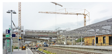
Noch gebietet der Prellbock für die S 3 Halt am Ostkreuz. Dahinter sind die beiden neuen geschwungenen Brücken der Südringkurve zu sehen, davor die wiederaufgebaute Fußgängerbrücke. Rechts ist der erneuerte Bahnsteig D mit den Dachstützen und der Aufsichtsbude im historischen Stil zu sehen. (Foto: Florian Müller)
