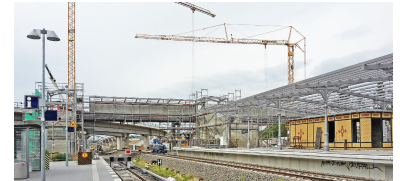
Noch gebietet der Prellbock für die S 3 Halt am Ostkreuz. Dahinter sind die beiden neuen geschwungenen Brücken der Südringkurve zu sehen, davor die wiederaufgebaute Fußgängerbrücke. Rechts ist der erneuerte Bahnsteig D mit den Dachstützen und der Aufsichtsbude im historischen Stil zu sehen. (Foto: Florian Müller)
