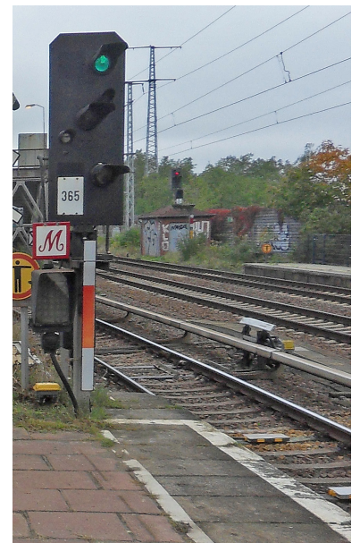
Das neue Zugsicherungssystem »ZBS« (Kasten im Gleis) löst nach und nach die alte Fahrsperre (weißer Anschlag neben dem Gleis) ab. Dazu sind umfangliche Streckensperrungen nötig, so auf der Stadtbahn noch bis Sommer 2017. (Foto: IGEB)
