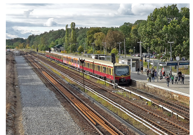
Die vorbereitenden Arbeiten für den Umbau des Bahnhofs Strausberg haben begonnen. Dabei sollen die Gleise von S- und Regionalbahn, die bisher gemeinschaftlich genutzt werden, getrennt werden. Links neben dem S-Bahn-Gleis soll ein neuer Regionalbahnsteig entstehen. So könnten die S-Bahn-Fahrgäste nach beiden Seiten aus dem Zug aussteigen - zum Ausgang oder zum Umstieg zum Regionalverkehr. Diese kundenfreundliche Lösung birgt allerdings technische und zulassungsrechtliche Probleme, die hoffentlich noch gelöst werden können. (Foto: Florian Müller, Mitte Oktober 2016)
