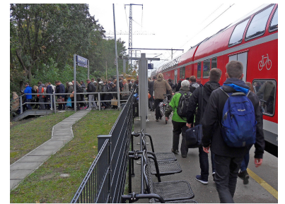
Der Regionalbahnhof in Karlshorst wird gut nachgefragt. Auf der linken Seite ist ausreichend Platz, um das Gleis stadtauswärts zu verlegen und einen neuen Mittelbahnsteig anzulegen. (Foto: Tom Gerlich)
