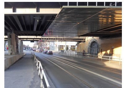
Die heute genutzte Fahrbahn wird neu aufgeteilt. Links, direkt neben dem Pfeiler, entsteht der linke Fahrstreifen. Dort, wo heute Gleis und Fahrspur Richtung Schöneweide liegen, entstehen Gleis und rechter Fahrstreifen Richtung Tierpark. Das heutige Gleis Richtung Norden wird zum Haltestellenbereich, rechts daneben entsteht der Radweg, der Haltestelle und Fußweg etwa mittig zerschneidet (Foto: Tom Gerlich)
