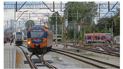
Bahnhof Zielona Góra (Grünberg). Die »Oderbahn« Szczecin-Zielona Góra--Wroclaw wird zurzeit schrittweise ausgebaut. Damit werden seitens der Infrastruktur Voraussetzungen für ein deutlich attraktiveres Angebot auch zwischen Berlin und Zielona Góra geschaffen. (Foto: Christian Schultz)
