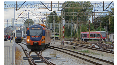
Bahnhof Zielona Góra (Grünberg). Die »Oderbahn« Szczecin-Zielona Góra--Wroclaw wird zurzeit schrittweise ausgebaut. Damit werden seitens der Infrastruktur Voraussetzungen für ein deutlich attraktiveres Angebot auch zwischen Berlin und Zielona Góra geschaffen. (Foto: Christian Schultz)
