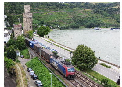
Der Kombinierte Verkehr ist ein wichtiges Element der Klimapolitik. Daher muss die sogenannte Verlagerungsinfrastruktur (Umschlaganlagen, Kapazitätserhöhung des Schienennetzes) forciert ausgebaut werden. (Foto: Christian Schultz)
