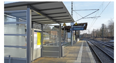
Der neue Regionalbahnsteig Potsdam Griebnitzsee, Fahrtrichtung Potsdam Hbf: Damit an dieser seit Jahren angekündigten und im Dezember 2016 endlich fertiggestellten Bahnsteigkante die aus Berlin kommenden RB-Züge auch halten können, hat man andere Halte in Berlin geopfert. Der Bahnsteig hat 5 Buswartehäuschen und immerhin einen LCD-Zugzielanzeiger. Der Aufzug soll erst am 27. Januar in Betrieb gehen. (Foto: Florian Müller)
