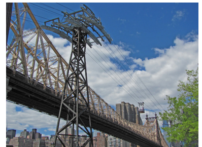
Die »Roosevelt Island Tramway« in New York verläuft parallel zur Queensboro Bridge. Die beiden Kabinen fahren unabhängig voneinander auf eigener Bahn und können aufgrund von je zwei Tragseilen im Abstand von 4,2 Metern auch bei Windgeschwindigkeiten über 80 km/h stabil fahren. Jede Kabine fasst 110 Fahrgäste und einen Fahrer. (Foto: Reinhard Dietrich/Wikipedia)
