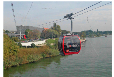
Im Herbst 2013 wurde die Seilbahn in Wrocław (Breslau) eröffnet. Sie verbindet das Hauptgelände der Technischen Universität mit dem neuen Forschungs- und Bildungszentrum »Geo-Centrum« auf der anderen Seite der Oder. 373 Meter lang, besitzt die »Polinka« genannte Anlage zwei hin- und her pendelnde Kabinen für je 15 Passagiere. Damit kann sie pro Stunde 366 Personen transportieren. Sie wird von der Hochschule betrieben, ist aber öffentlich zugänglich. Kostenlos befördert werden jedoch nur die rund 34 000 Studenten und über 4000 Mitarbeiter der TU. (Foto: Frank Lammers, Okt. 2016)
